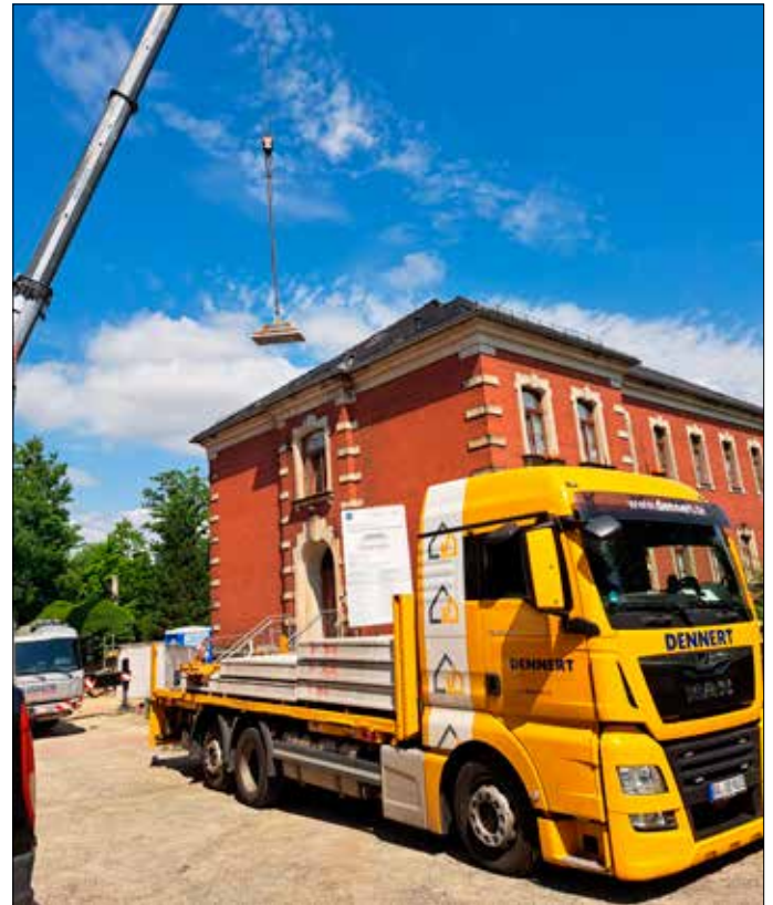
Montage der Fertigteil-Deckenplatten am eingeschossigen Erweiterungsbau Haus II der Pestalozzi-Grundschule Großschönau
