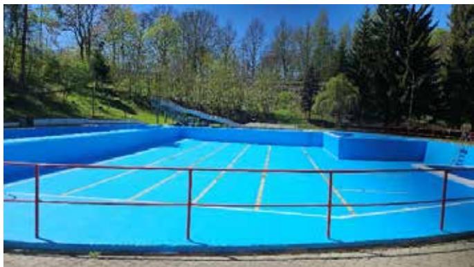
Das Schwimmbecken wurde ausgebaut und frisch gestrichen. Erstrahlt wieder in leuchtendem Blau.
