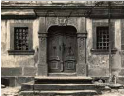
Der Türstock im Original Mauerweg 33 (Foto: Archiv DDFM)
